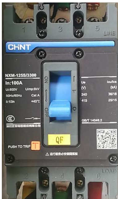
图2.1-1下电箱短路器 (分断状态)
