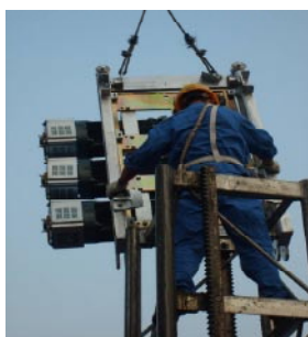
图1.3-8 驱动系统的安装
